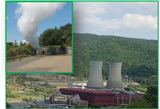
Centrale geotermica Larderello - Enel Green Power
