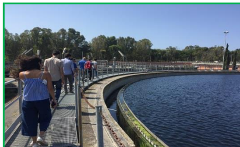
Impianto depurazione reflui - Acea
