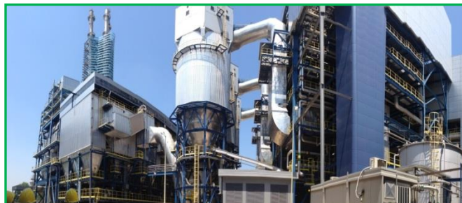
Termovalorizzatore Acerra - A2A
